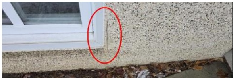
Le crépi est endommagé. Suite à la prise de possession, faire identifier et réparer la cause le crépi endommagé là ou nécessaire.
