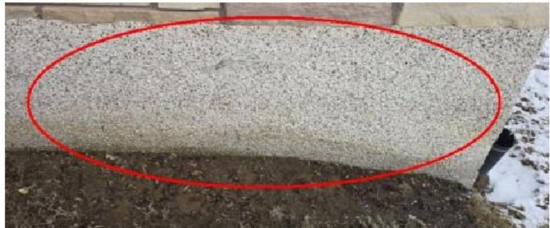
Le crépi est endommagé. Suite à la prise de possession, faire identifier et réparer la cause le crépi endommagé là ou nécessaire.
